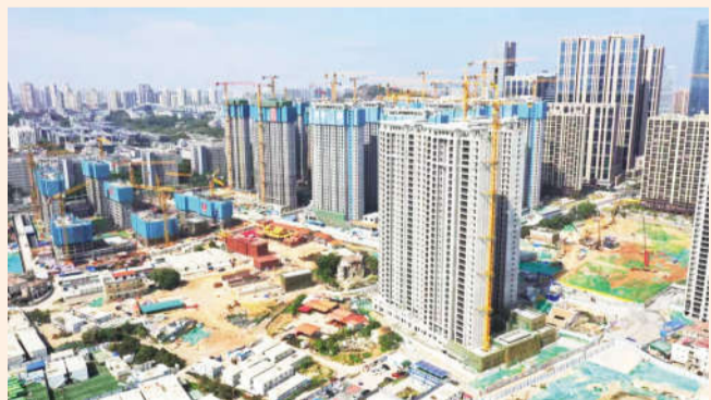
厦门何厝岭兜片区综合配套工程项目 来源:思明快报
