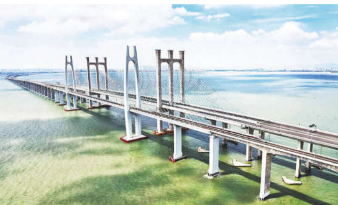
列车行驶在福厦高铁泉州湾跨海大桥上
