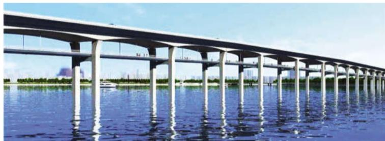
外,其余桥梁均实现了主体建成。溪东大桥位于新机场片区,跨越南港海域,连接大嶝岛和莲河两岸,是厦门市首座采用上、下层结构,设置“机动车道”和“非机动车道”的跨海大桥,即上层为机动车
