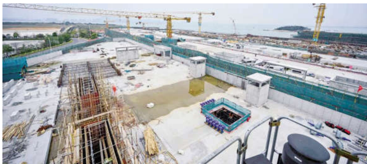
高崎污水处理厂一期工程主体结构封顶。(林铭尧 摄)
