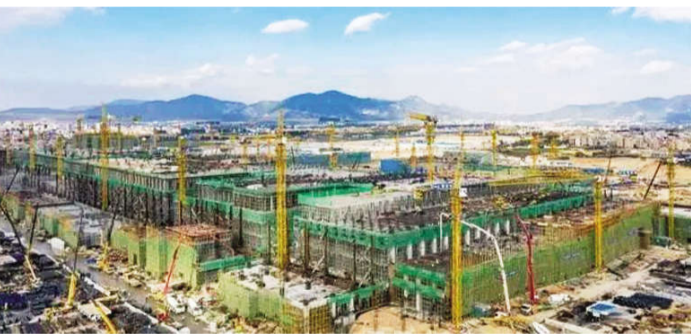
天马第 6 代柔性 AMOLED 生产线项目现场
