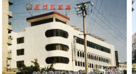
90年代厦门包装厂(《厦门建设》)
