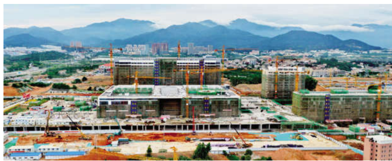
马銮湾医院主体基本建成。
