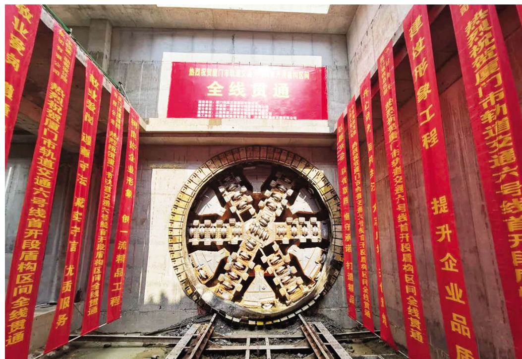
5 月 13 日上午,地铁 6 号线马銮湾跨海段隧道全部贯通。(王协云 摄)
