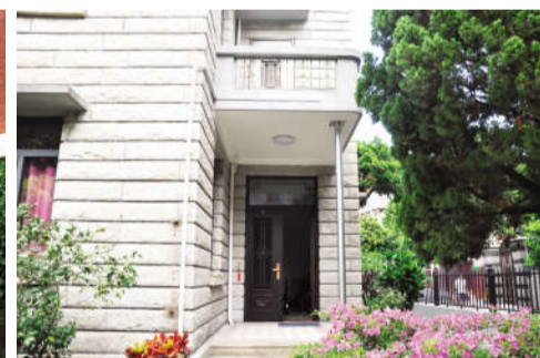
条石建筑结构耐看,半个多世纪来仍不显旧
