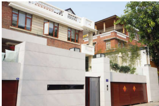
华侨新村翻新建筑
